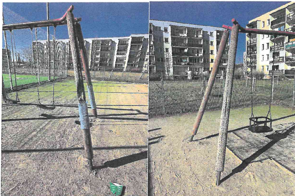
Fot. 1. i 2. Widoczne ubytki i uszkodzenia elementów drewnianych
